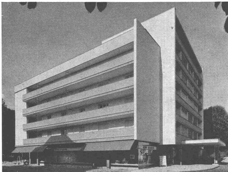
Farbenkonditionierung beim Fassadenanstrich
