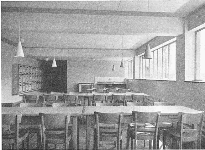
Bild 6. Essraum im Zwischengeschoss
