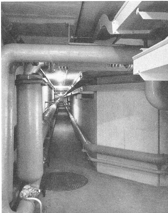
Bild 8. Begehbarer Leitungskanal
