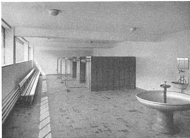
Bild 7. Garderobe- und Waschraum im Erdgeschoss
