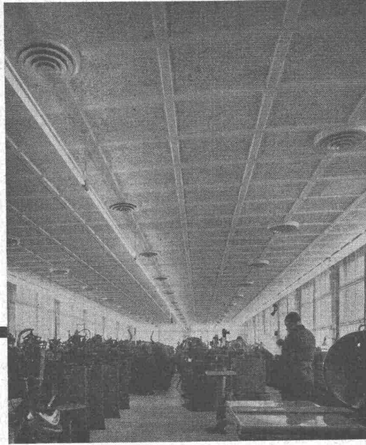
Klimaanlage «System Häusler» in Uhrenfabrik
