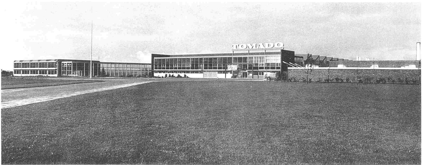
Metallwarenfabrik in Etten-Leur. Industriebau von einer fast raffinierten Einfachheit, welche mit durchaus verantwortbaren Mitteln einen starken Effekt erreicht. Arch. H. A. Maaskant & L. v. Herwijnen
