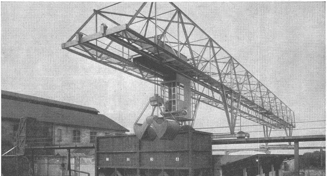
Verladebrücke in Schweisskonstruktion 2,5 t Tragkraft, 46 m Länge
