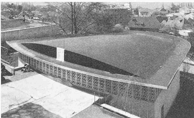
Bild 22. Aula der Höheren Töcherschule in Lausanne, 1954. Flache Schalenkuppel über einem trapezförmigen Grundriss, wobei die zwei gegenüberliegenden Seiten kreisförmig mit 7,30 m, bzw. 37,80 m Halbmesser begrenzt sind. Längsaxe 20,80 m Spannweite, grösste Spannweite in der Querrichtung 22,80 m, Dicke 15 cm. Vorspannung des Schalenrandes durch 4 Kabel zu 12 \varnothing 5 des Systems Freyssinet, Spannkraft 100 t, Modelluntersuchung im Laboratorium für Baustatik der Ecole Polytechnique der Universität Lausanne, Leitung Prof. Fr. Panchaud. Entwurf der Tragkonstruktion: Bureau A. Villard, Lausanne. Ausführung: Bauunternehmung Riva S. A., Lausanne
