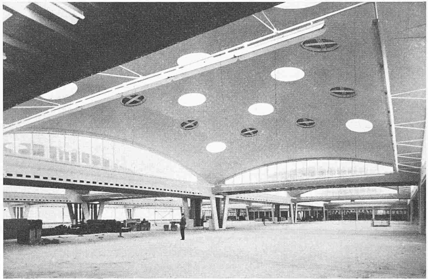
Bild 17. Wolldeckenfabrik Zoeppritz in Mergelstetten (Deutschland), 1953. Länge 96 m, Breite 48 m. Zwölf einseitig eingespannte und vorgespannte zylindrische Shedschalen: Spannweite 21 m, Breite 7,50 m, Vorspannung der oberen und unteren Ränder durch gekrümmte Leoba-Spannglieder des Systems Baur-Leonhardt, 4 Kabel im oberen Rand, Spannkraft 100 t, 8 Kabel im unteren Rand als Rinnenträger, Spannkraft 200 t, Schalen in einem mittleren vorgespannten Kastenträger 350/380 cm von 36,20 m Spannweite mit 9,90 m Auskragung eingespannt. Die einzigen Stützen in dieser Halle sind die 2 Liftschächte in der Mitte. Entwurf der Tragkonstruktion: Bureau Dr. Leonhardt, und Mitarbeiter Ing. W. Pieckert, Stuttgart. Ausführung: Bauunternehmung Karl Kübler, Stuttgart
