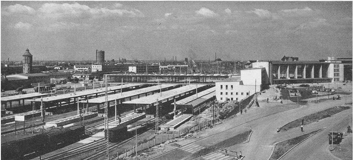
Bild 3. Gesamtansicht der Bahnsteige mit Empfangsgebäude
