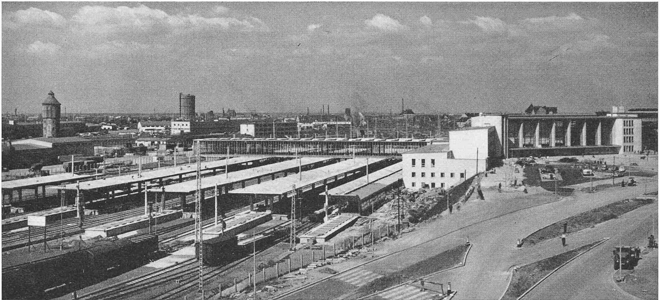
Bild 3. Gesamtansicht der Bahnsteige mit Empfangsgebäude
