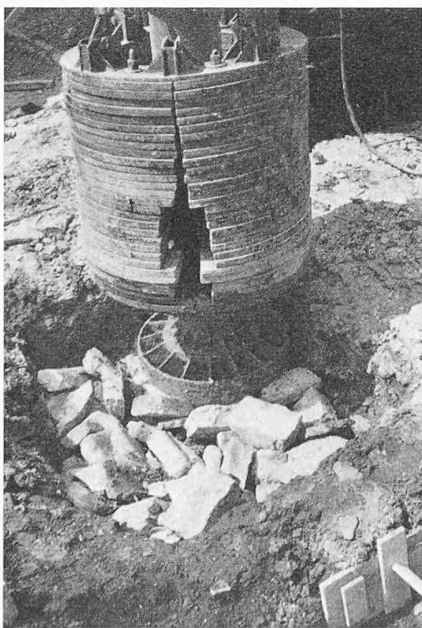
Bild 3. Aufsetzen des Mammutrüttlers auf eine Lage Grobsteine
