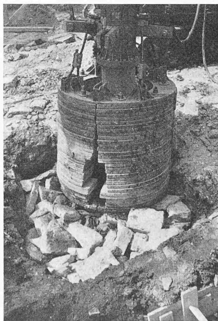
Bild 4. Der Einsinkvorgang ist beendet, sobald die Auflast am Boden aufsteht
