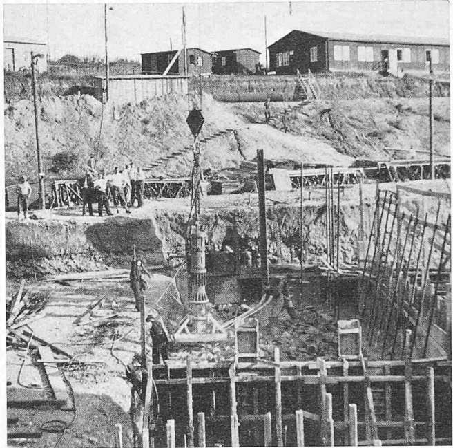
Bild 6. Bruchsteinbetonerzeugung mit Mammutrüttler beim Bau der Staumauer Beyenburg
