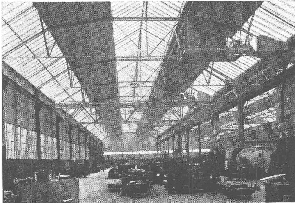
Produktionshalle, Kranerüst in Leichtmetall
