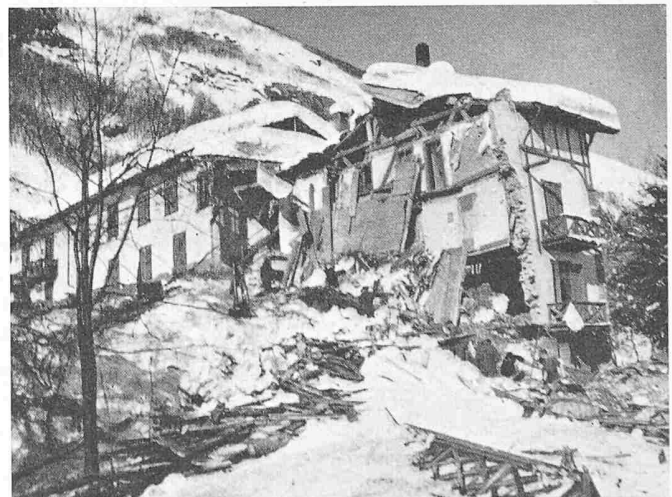
Bild 22. Haus in Vals-Platz, dessen eine Hälfte 1951 von einer Lawine scharf abgeschnitten wurde
