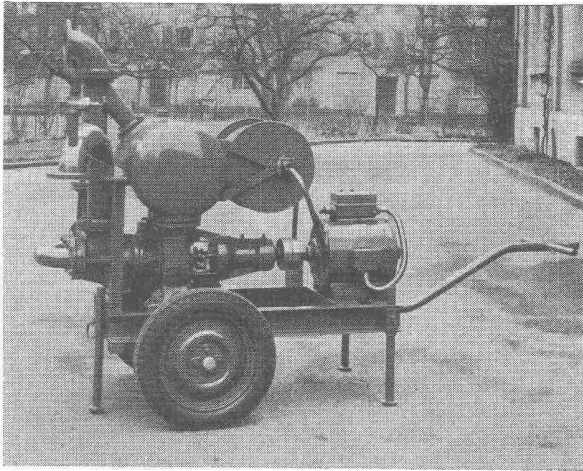
Bild 1. Auf Pneurädern montierte Baupumpe mit Elektromotor und Kabeltrommel
