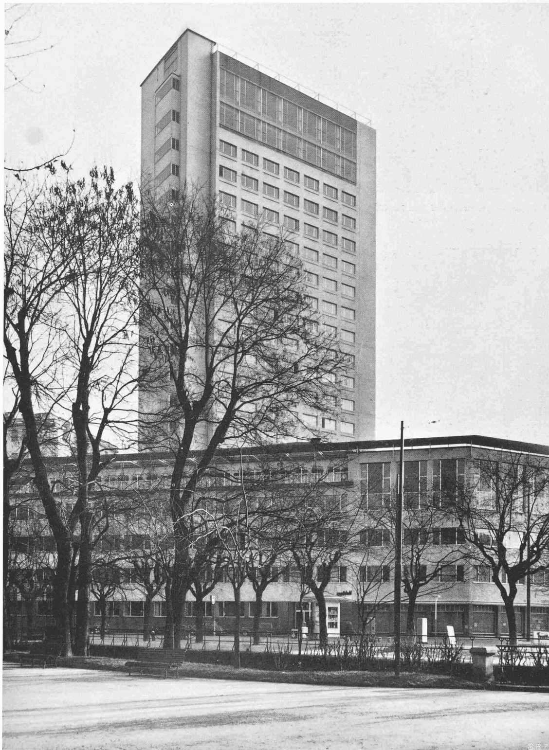
Bild 11. Hochhaus, Westfassade, und langer Flügel des Vorderbaues an der Via Palestro
