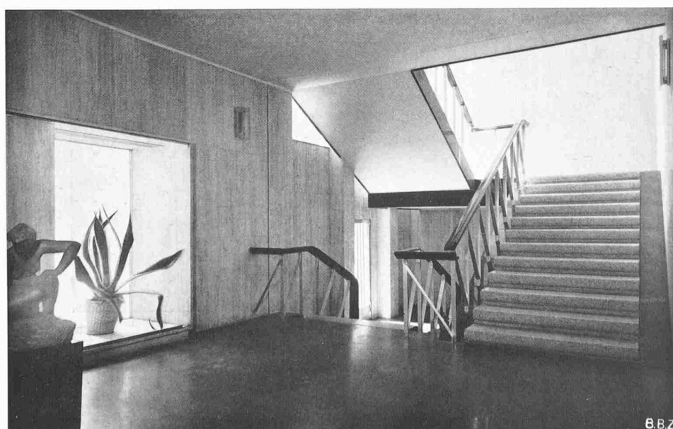
Bild 26. Antritt der Haupttreppe in der Halle des Vorderhauses, Wangen und Boden schwarzer Marmor, Stufen ge- schliffener heller Granit
