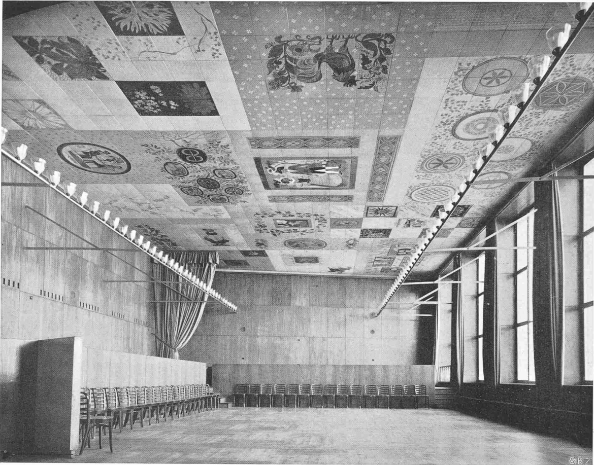
Bild 22. Der grosse Festsaal. Wände Ahorntäfer, Deckengemälde auf Pavatexplatten (Noldi Soland)
