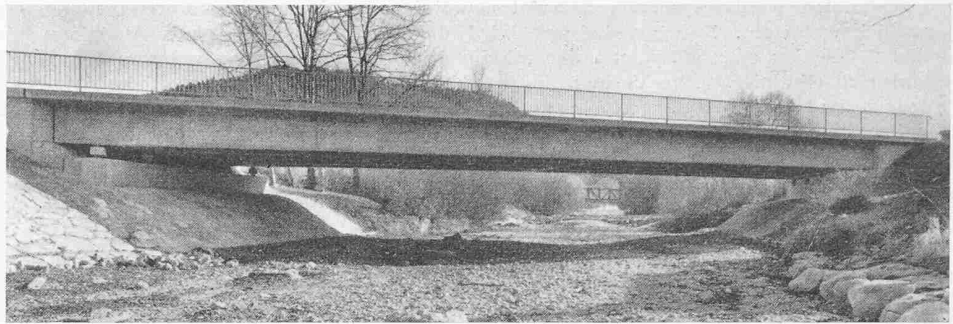
Bilder 17 und 18. Tössbrücke Wila (Kt. Zürich) 1952. Plattenbalkenbrücke (Schiefe: \alpha = 60^\circ ) mit fünf Trägern in einer Oeffnung l = 29,6 m, konstante Bauhöhe d = 114 cm, d/l = 26 . Spannkraft V = 2910 t mit vier Spannblöcken. Beschränkte Quervorspannung mit Spannglieder 12 \times 5 \phi , V = 24 t des Systemes BBRV. Entwurf: Ingenieurbureau E. Schubiger, Zürich. Ausführung: Locher & Co. und Stahlton AG., Zürich.
