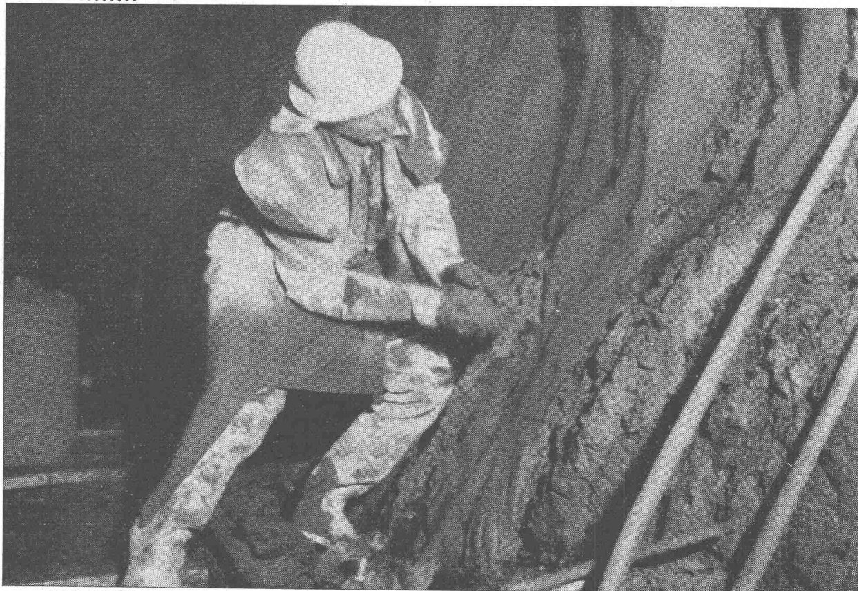
Maggia-Kraftwerke AG. Locarno. Vordichtung des Druckstollens Galleria Verbano mit BARRA-RAPID U.
