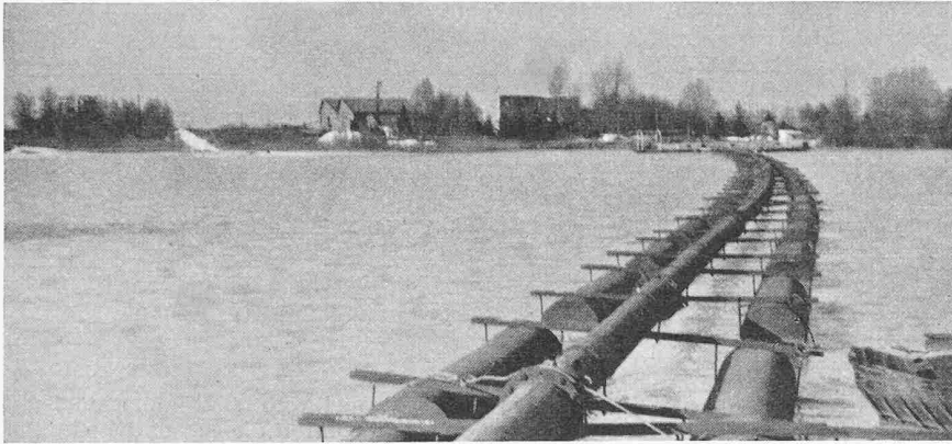
Bild 3. Gewinnung aus dem Grundwasser mit Saugbagger
