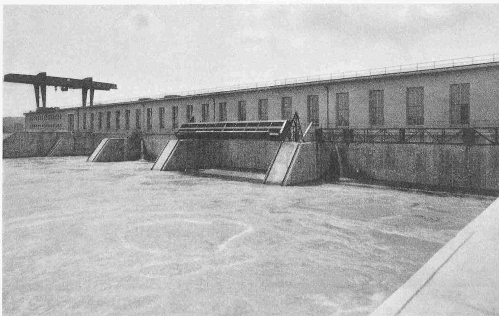
Bild 28. Ansicht des Krafthauses von der Unterwasserseite
