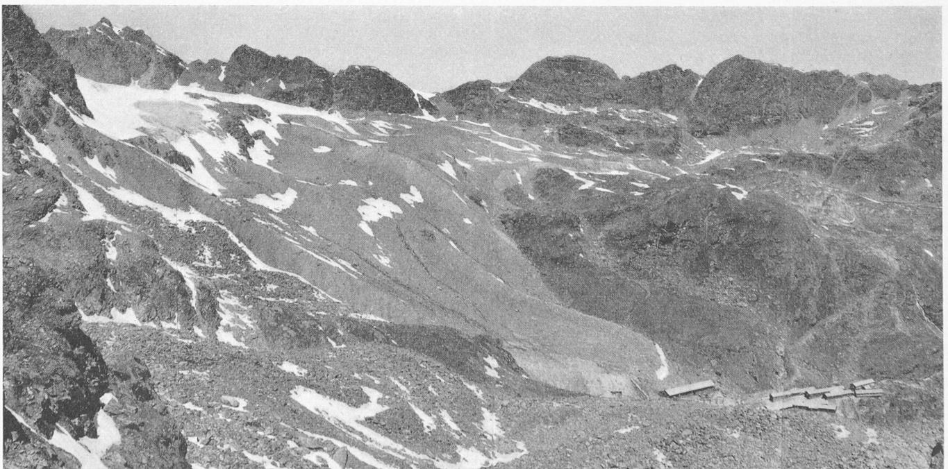
Bild 11. Stirnmoräne bei Parfleuri im Abbau, als Betonzuschlagstoff für die Gewichtstamauer Grande Dixence. Photo Grande Dixence S. A.
