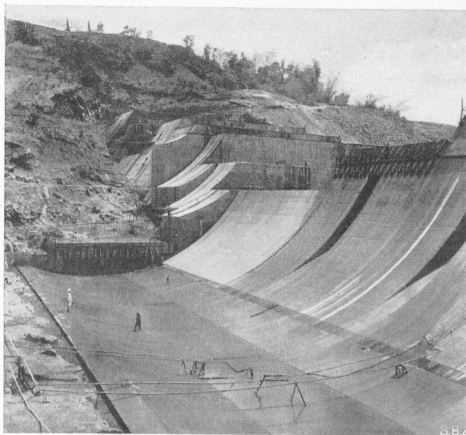
Bild 14. Vaitarna-Staumauer, Bauzustand Juni 1953.
