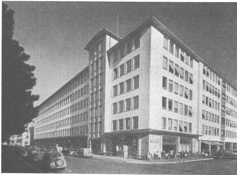
Geschäftshaus Claridenhof, Zürich - Grundwasserisolierung 3200 m 2 Bauleitung: W. Henauer, Architekt, Zürich
