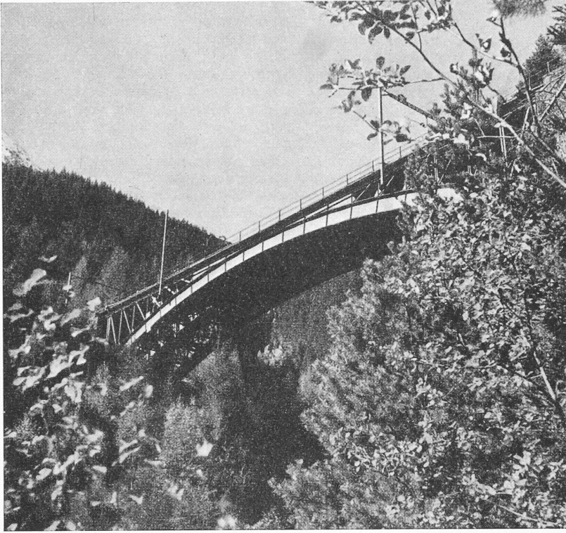
Bild 58. Rohrbachbrücke der SBB bei Wassen, erbaut 1891; stählerner Zweigelenkbogen von 60 m Stützweite. Ausdruck der Tragkraft ohne Masse
