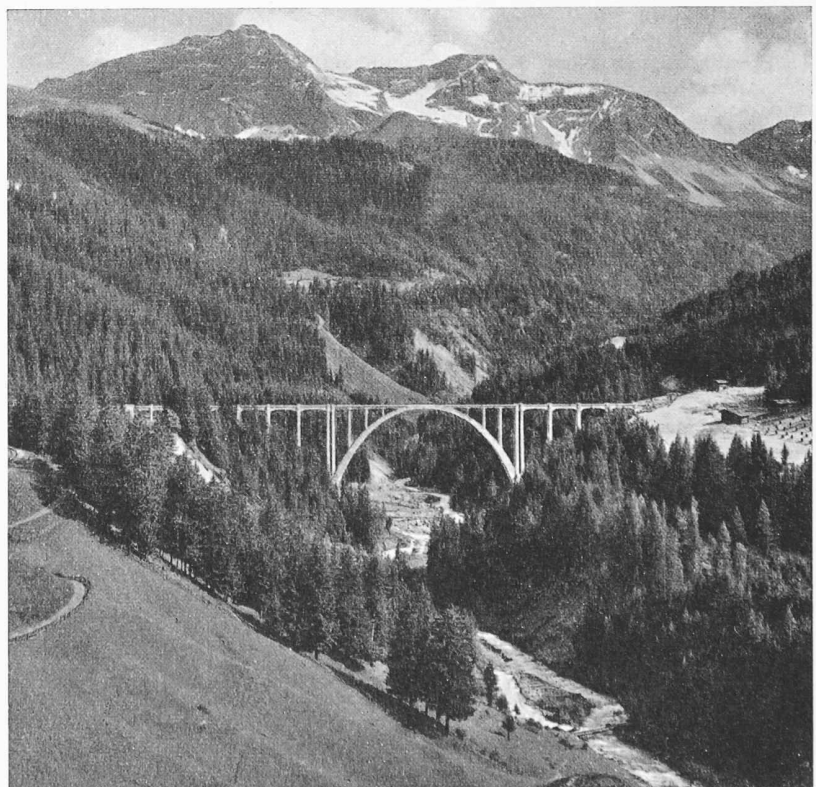
Bild 41. Langwieser Viadukt; Stützweite des grossen Bogens 100 m
