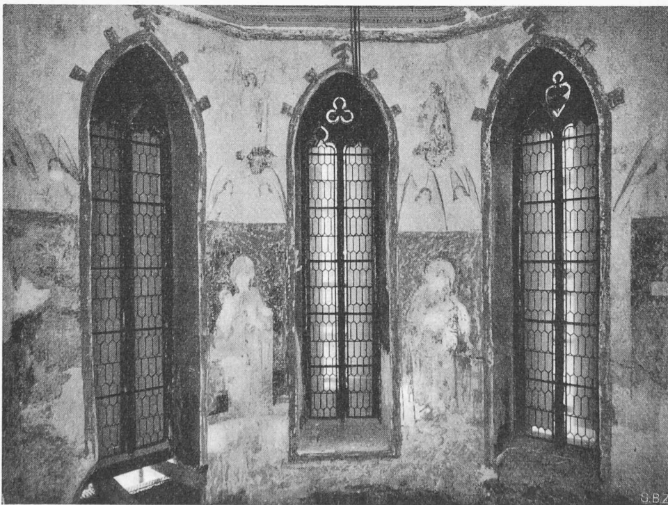
Bild 3. Der Chor der reformierten Pfarrkirche von Pratteln (Baselland) mit den während der Restauration freigelegten gotischen Wandgemälden vor ihrer Zerstörung (einzig diese Aufnahme wurde vom Verfasser leicht retuschiert, um zu zeigen, wie die Gesamtwirkung nach einer Restauration der Gemälde ungefähr gewirkt hätte). Links vom Mittelfenster Maria mit Kind
