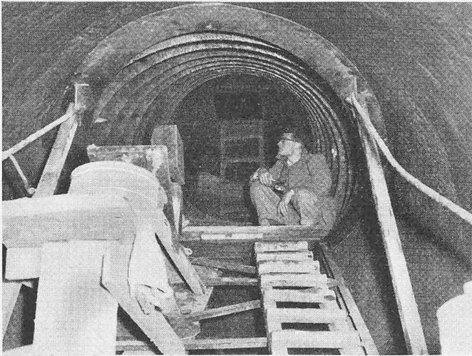
Fig. 8. Coffrage glissant vu par l'arrière
