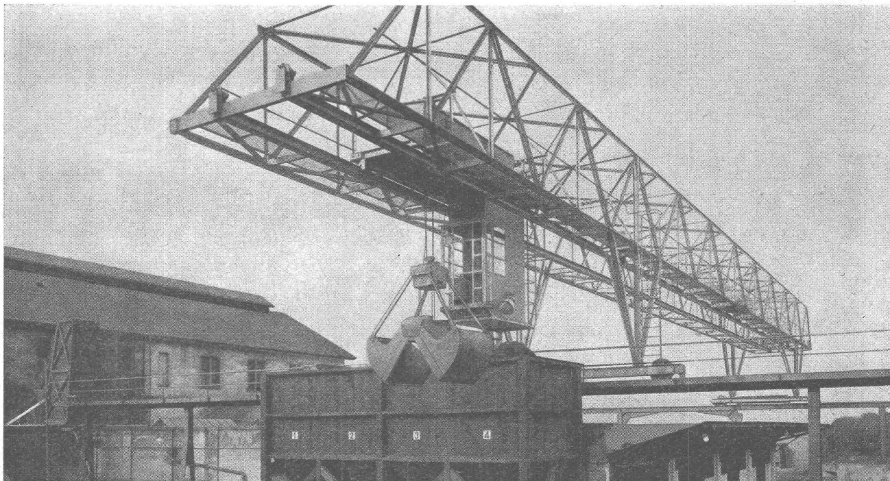
Verladebrücke in Schweisskonstruktion 2,5 t Tragkraft, 46 m Länge
