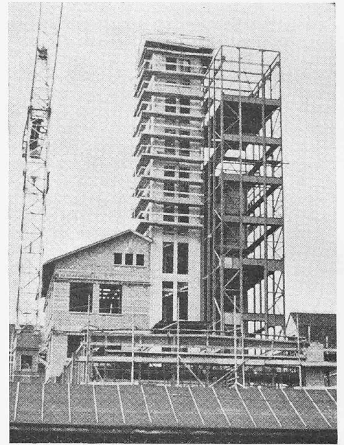
Bild 27. Stahlskelett des Turmes
