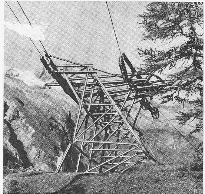
Bild 3. Winkelmast der Gauliseilbahn
