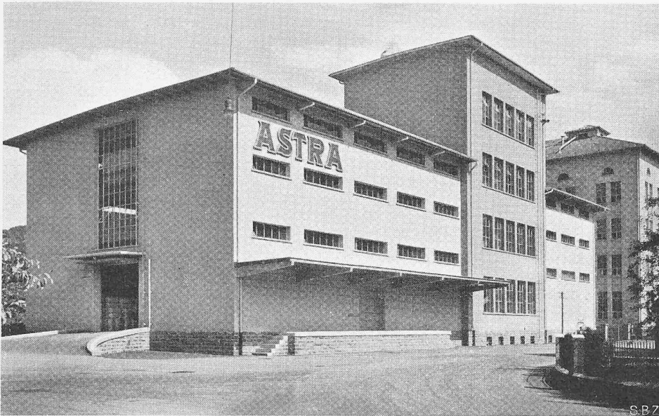
Bild 11. Lagerhaus mit Schrottkühl- und Mahlanlage, rechts Extraktionsgebäude, gesehen von Nordwesten Photos Henn, Bern
