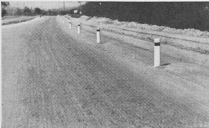
Bilder 8 und 9. Radstreifen durch Pfosten von der Fahrbahn getrennt. Hat sich nicht bewährt, die Pfosten sind durch eine optische Markierung ersetzt worden (Bild 9).
