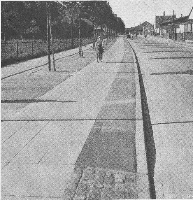
Bilder 12 und 13, Radwege durch verschiedenartige Schutzstreifen von der Fahrbahn getrennt.
