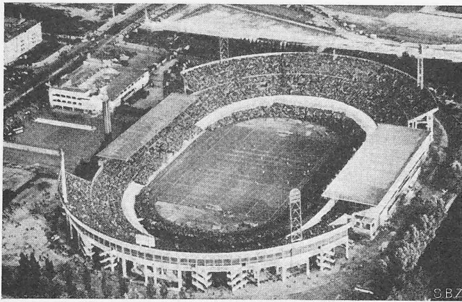
Bild 4. Olympia-Stadion in Amsterdam, 1928, aufgestockt 1937, Fussball, Leichtathletik, Radrennen, Eisenbetonbau, 65 000 Plätze + 10 000 provisorische Aschenbahnplätze. Arch. J. WILS [3].
