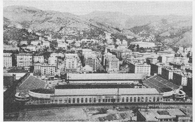
Bild 5. Fussballstadion in Genua mit Rundrampen. Neue Tribüne 1950, 45° Neigung, 70 000 Plätze. Ing. A. VICARI [4].
