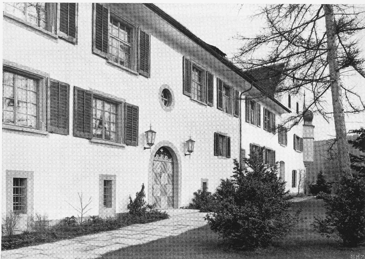
Umgebaute Westseite mit Haupteingang
