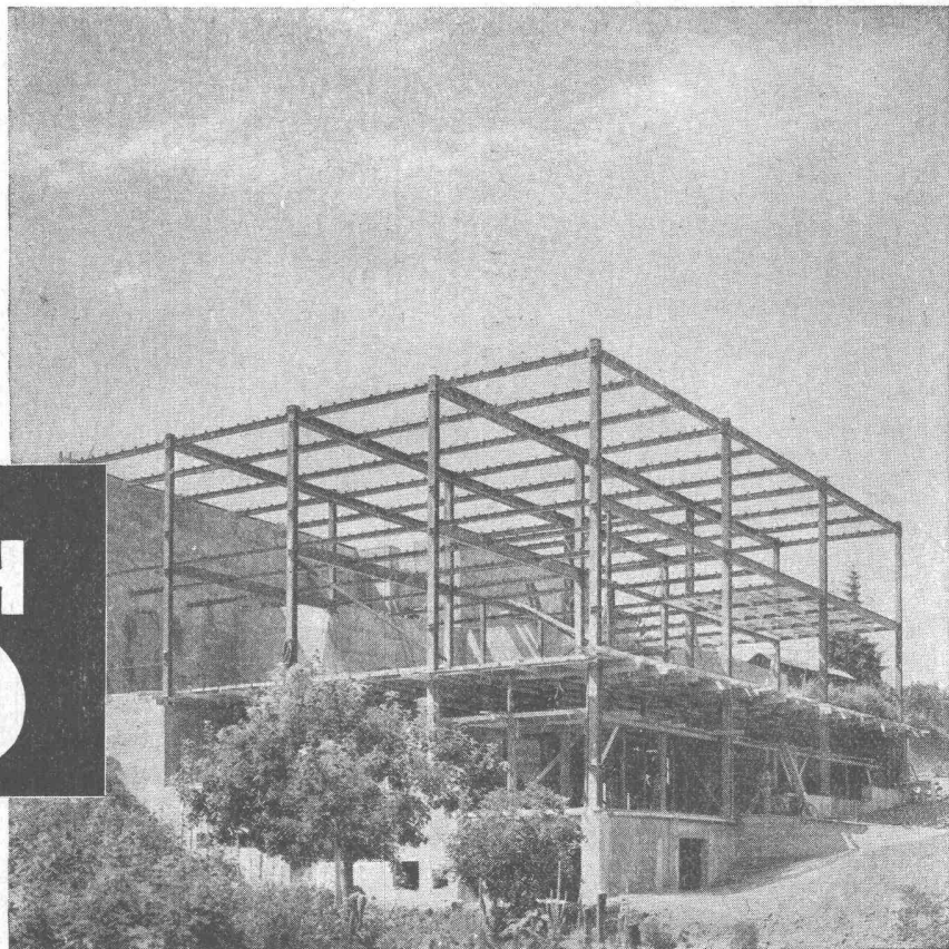
Stahlskelett für Fabrikneubau
