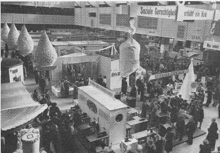
Allgemeine Hallenansicht 1943. Die Lockerung der Vorschriften gestattet den Ausstellern grössere Freiheiten.
