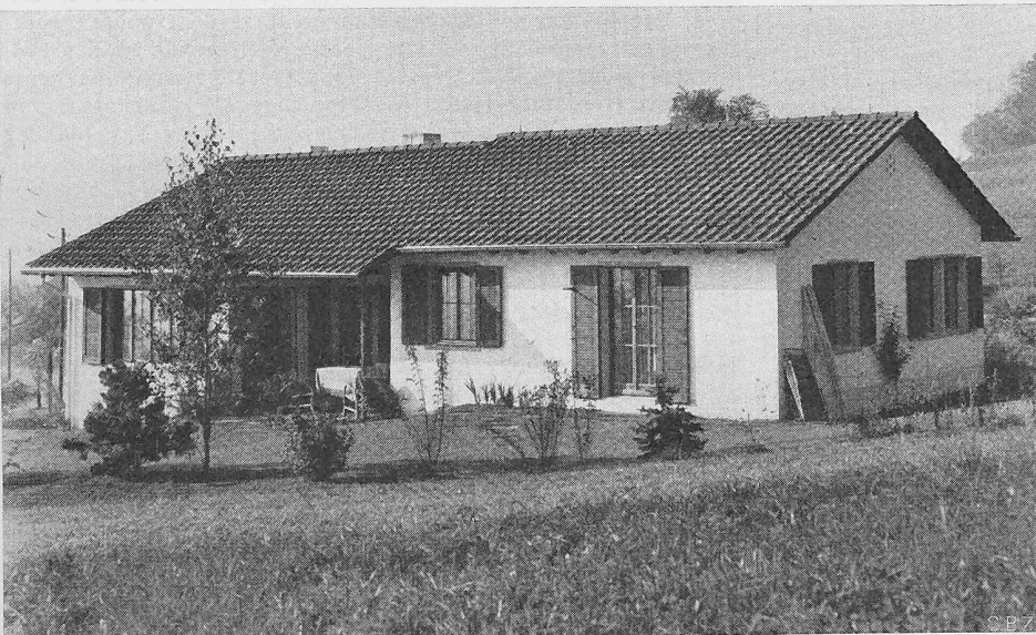
Bild 8. Ansicht aus Osten
