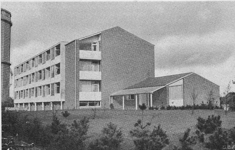
Bild 23. Wohnungen für junge Ehepaare in Gentofte. Scharfe Konturen, hervorgerufen durch Weglassen der Dachvorsprünge. Rechts der Kindergarten.
