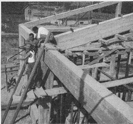
Bild 25. Fabrikneubau in Müntschemier. Vorgespannter Zugband für dreieckförmige Hallenbinder mit 20 m Spannweite, Vorspannkraft 40 t pro Zugband. Projekt: Ing.-Bureau Hartenbach & Wenger, Bern.
