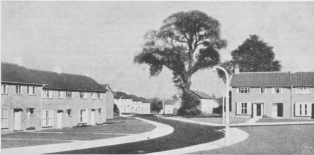
Bild 11. Harlow, Chippingfield. Im August 1950 bezogene Häuser mit zwei bzw. drei Schlafzimmern
