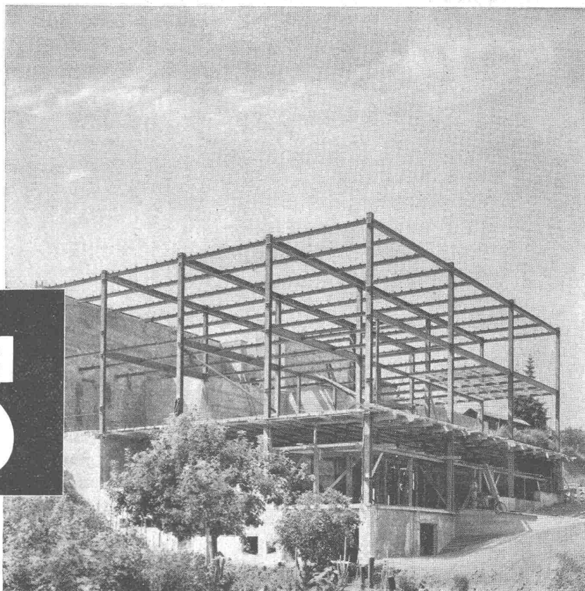
Stahlskelett für Fabrikneubau
