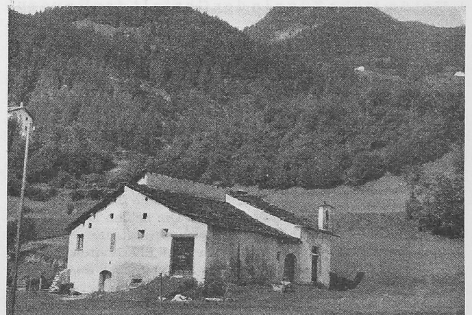
Bild 2. Bauernhaus von 1674 in Viale, St. Antonio, Puschlav, rd. 1000 m ü. M. Gegenüber dem Wirtschaftsgebäude liegt der Wohntrakt (Casa civile) weiter zurück. Die beiden Gebäude sind verschieden hoch
