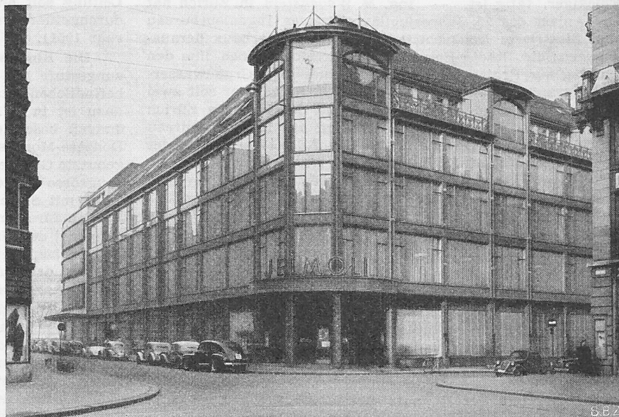
Bild 3. Warenhaus Jelmoli, 1898, Arch. H. STADLER & E. USTERI
