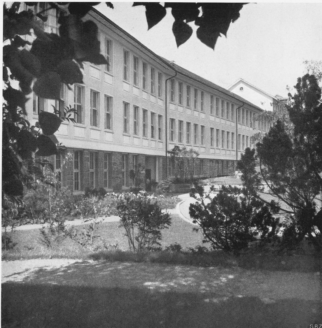
Bild 16. Ansicht des westlichen Klassenflügels aus Süden
