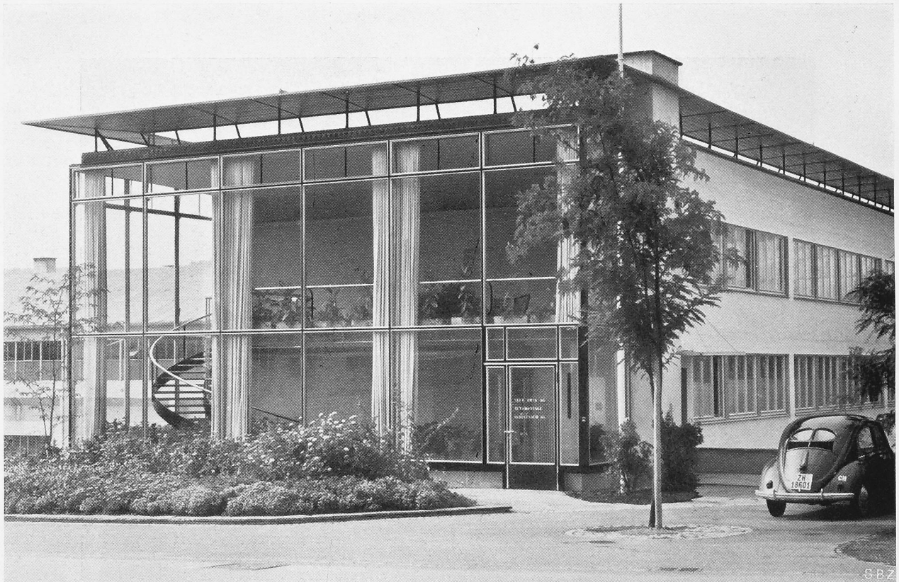
Bild 15. Die Eingangsfront von der Kantonsstrasse aus
