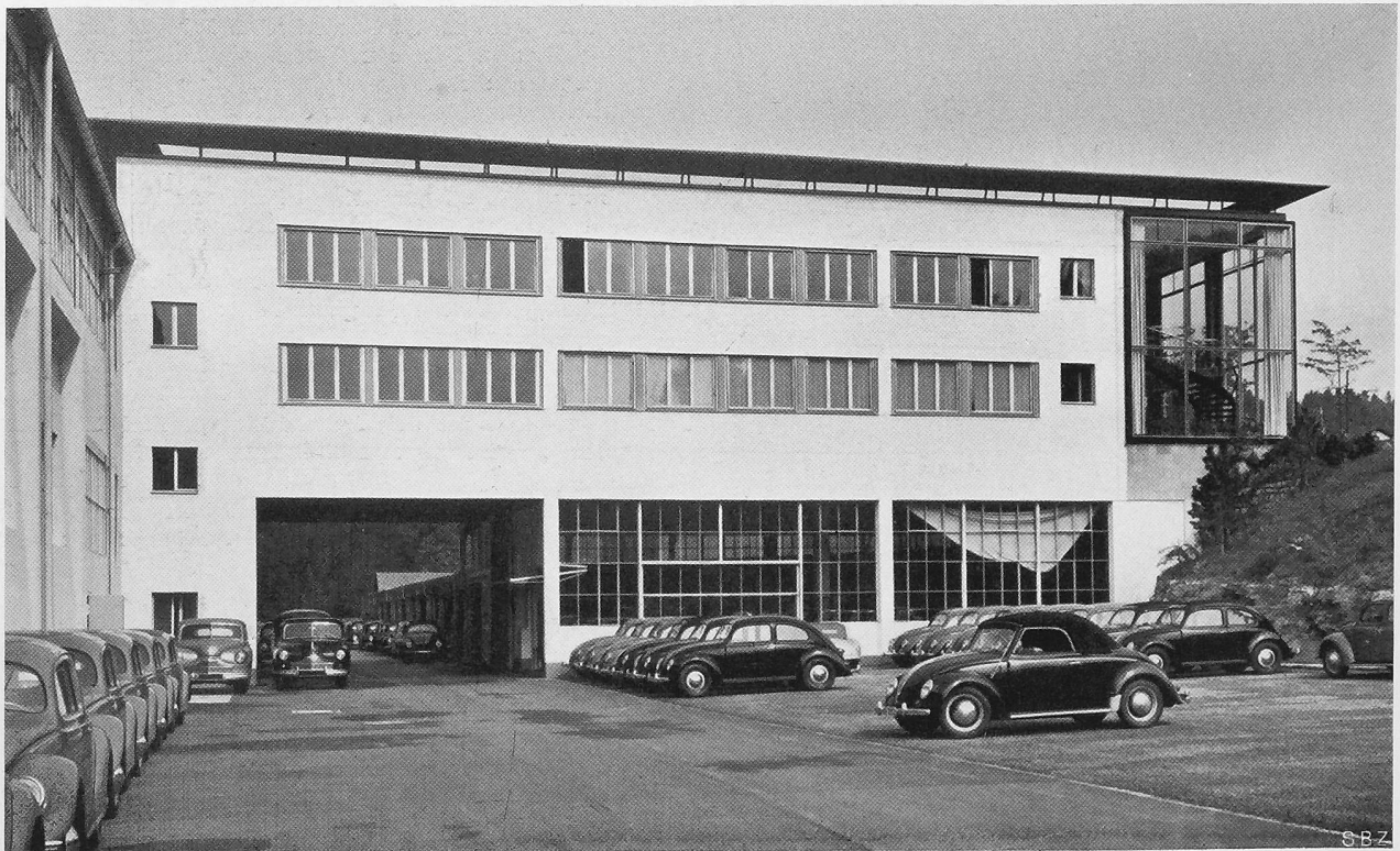
Bild 16. Südfassade des Zentralgebäudes
