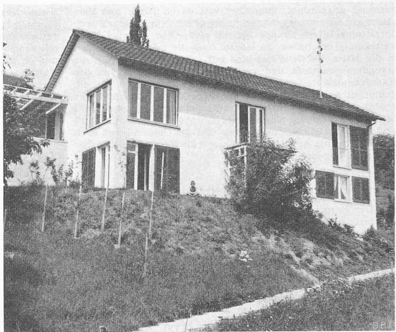
Bild 5. Talseite mit Zugang von der Schwandenstrasse
