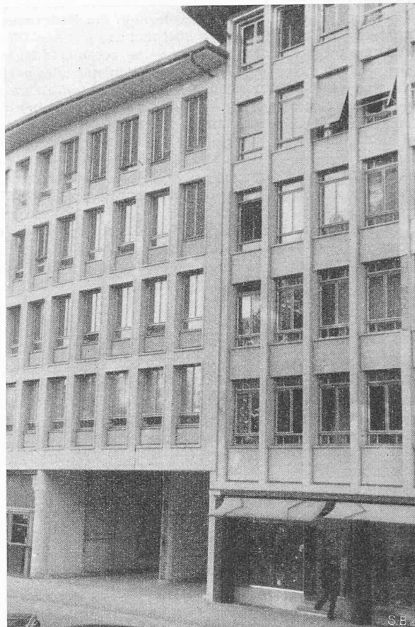
Bild 17. Fassade an der Talstrasse: rechts «Weltwoche», links das durch einen andern Bauherrn angebaute Geschäftshaus
