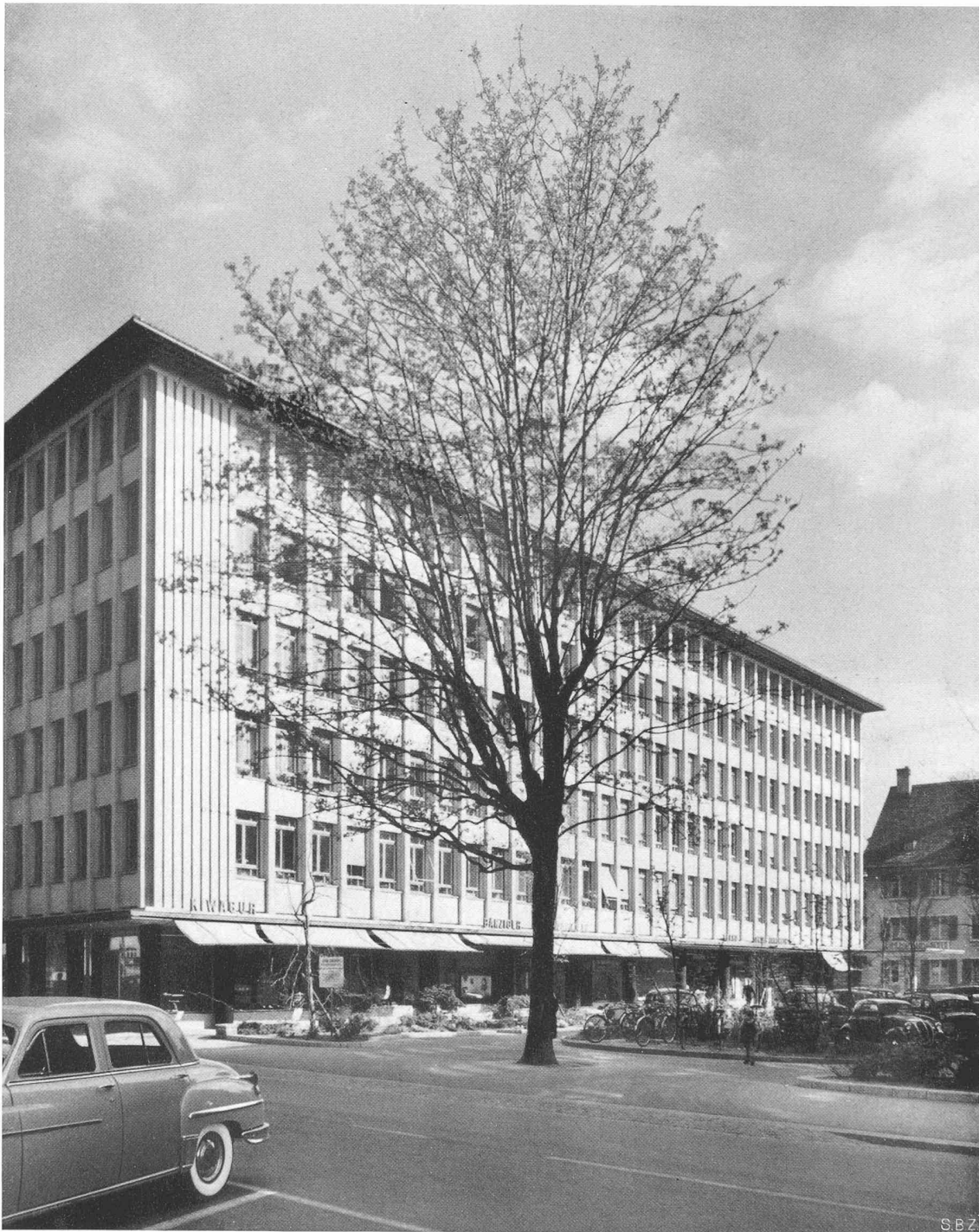
Bild 1. Ansicht der Hauptfassade mit Blick in den privaten, bepflanzten Parkplatz
