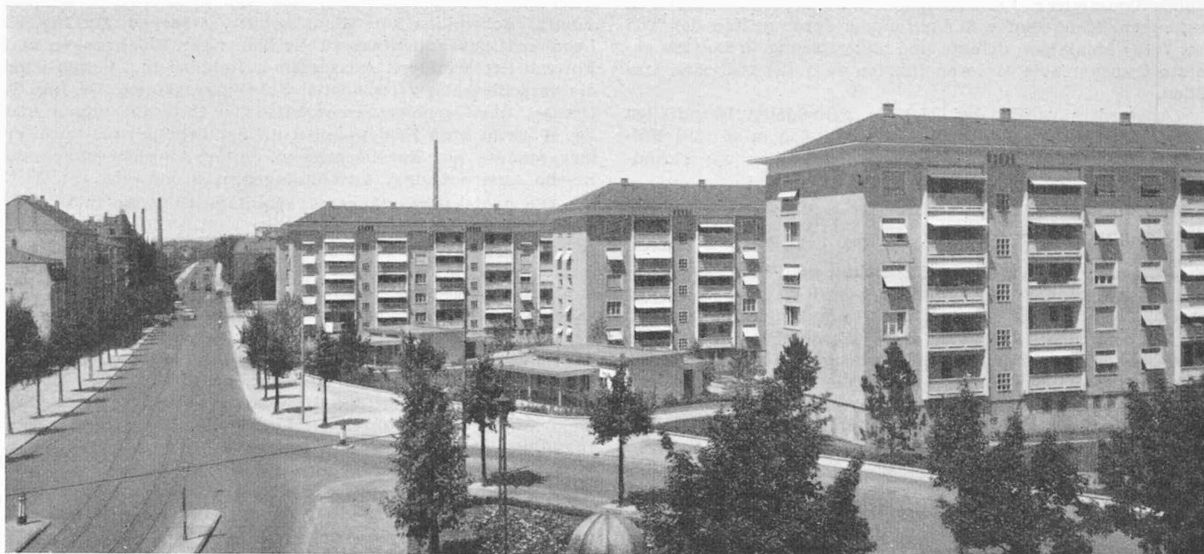
Bild 11. Angestellten- und Arbeitersiedlung der «Ciba» in Basel. Ansicht von Osten, links die Horburgstrasse. Architektengemeinschaft A. GFELLER, H. VON DER MÜHLL & P. OBERRAUCH, Basel
