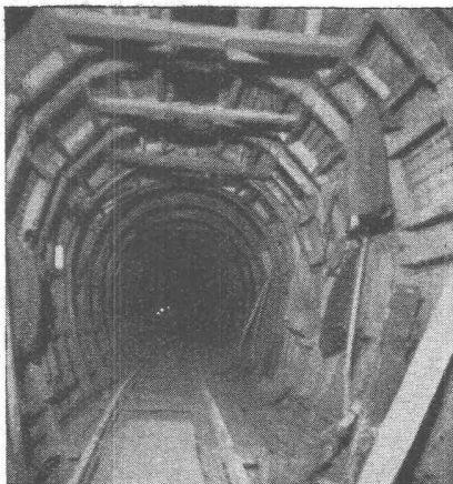
Stollenschalung (1100 lfm Stollen mit 30 lfm Schalung betoniert)
