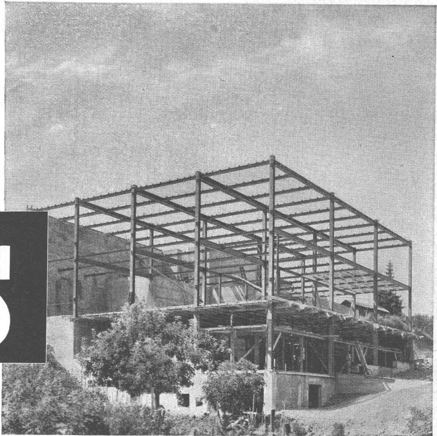
Stahlskelett für Fabrikneubau
