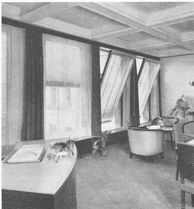
Bild 2. Carda-Fenster mit tiefer Brüstung
