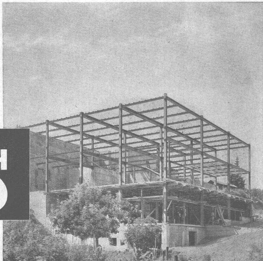
Stahlskelett für Fabrikgebäude
