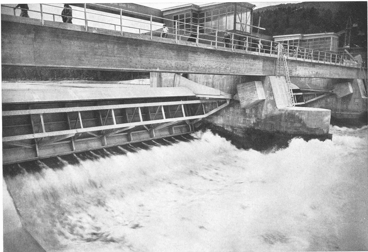
Bild 20. Stauwehr. Sektorhakenschütze der rechten Wehrröffnung
