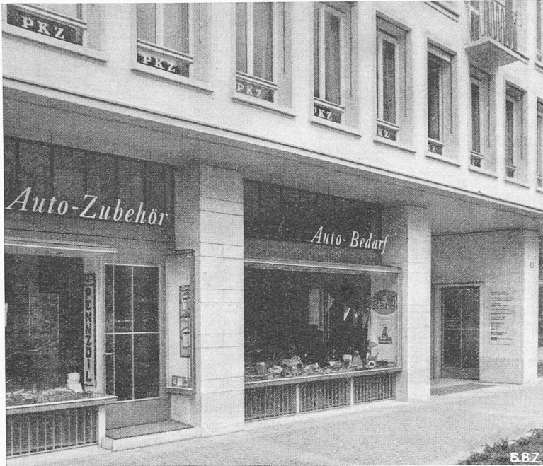
Bild 21. Schaufensterpartie an der Talstrasse
