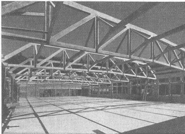
Eisenbetonfachwerk - Montagefertig
