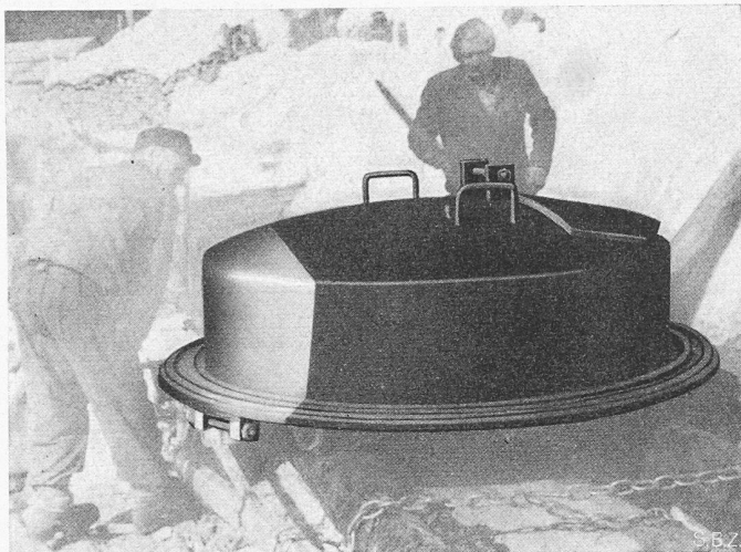
Bild 7. Als Schwimmkörper ausgebildeter Abschlussdeckel
